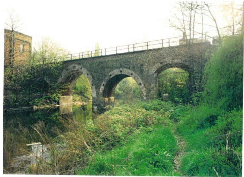
gesperrte Eisenbahnbrücke zwischen König-August-Brücke und Gießerbrücke (1992)
