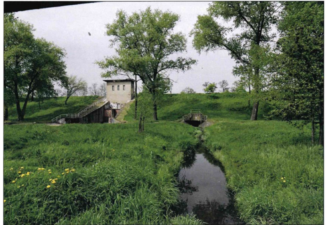
Elster-Saale-Kanal, Entlastungsanlage und Durchlass Zschampertbach, 2010, Wulf Hevers
