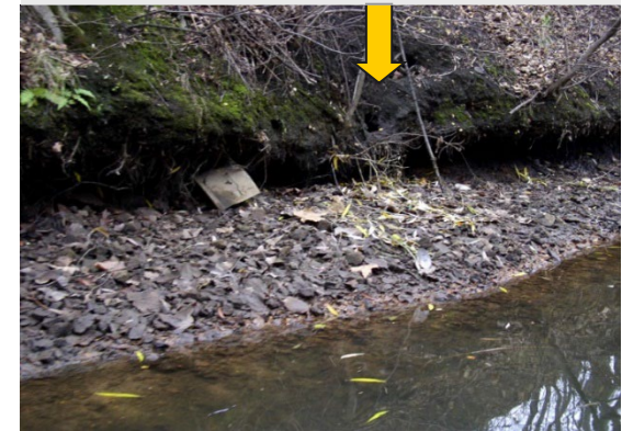
Böschungsfußschäden am Karl-Heine-Kanal
