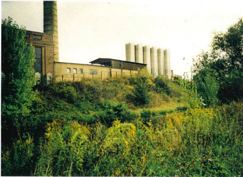
Texafol an der Luisenbrücke (1991)
