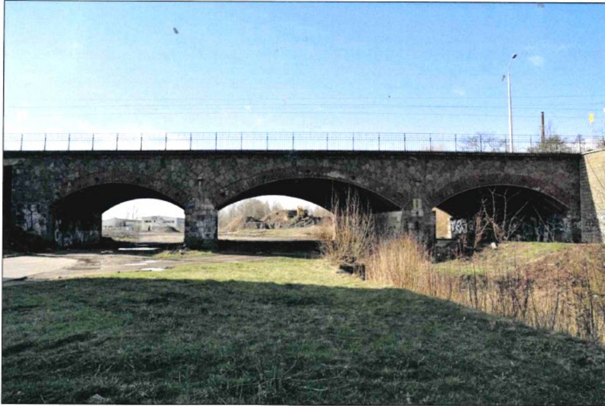
Luisenbrücke, Ende Karl-Heine-Kanal, 2010, Wulf Hevers
