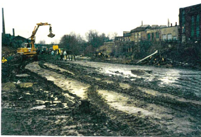
Beginn der Bauarbeiten 1992 Entschlammung Karl-Heine-Kanal
